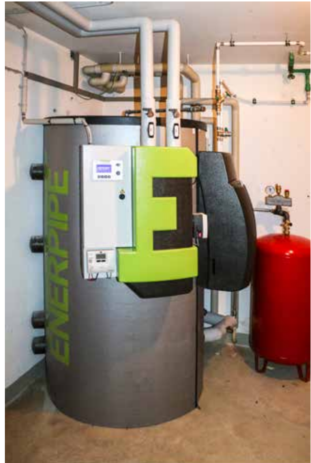
Abb. 1: Installiertes Pufferspeichersystem
