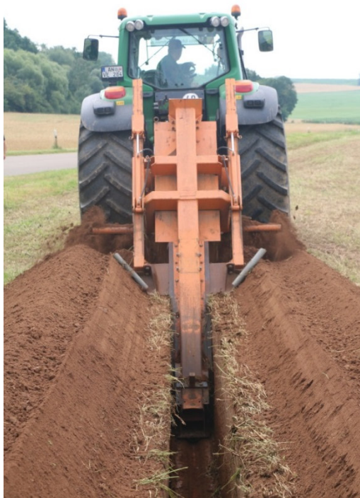
Grabenfräse + Verlegung der Wärmerohre
