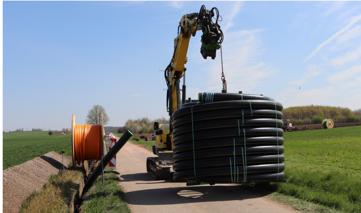
Grabenfräse + Verlegung der Wärmerohre
