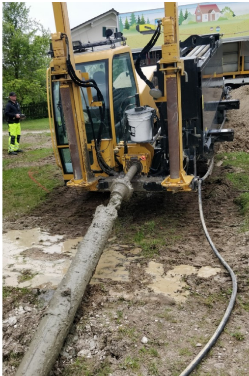
Grabenlose Verlegung im günstigen Spülbohrverfahren
