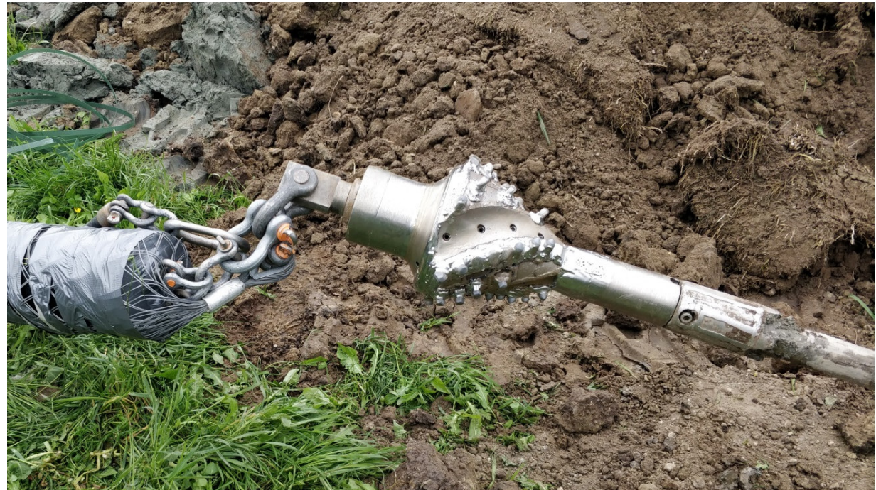
Grabenlose Verlegung im günstigen Spülbohrverfahren
