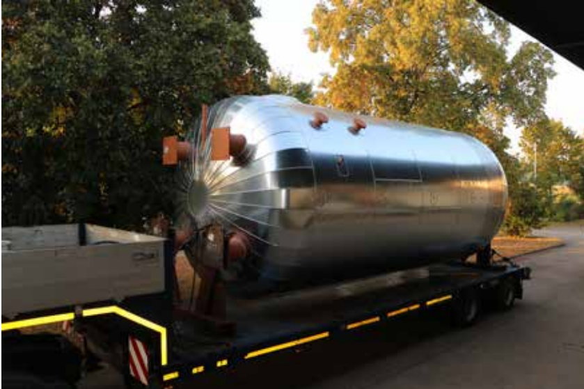
Anlieferung des Großpufferspeichers
